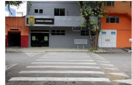
FIGURA 1.1 - FACHADA COM A PLACA
