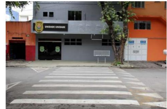
FIGURA 2.1 - FACHADA COM A PLACA
